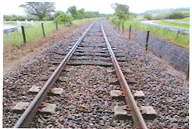
Zone de traverses hétérogènes sur du LRS datant de 1952 au PK 268+200
